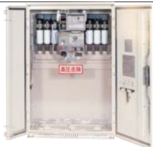
自立型高圧交流ガス開閉器 HV GAS-BREAK SWITCHBOARD
