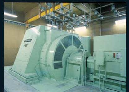
200MVA 短絡発電機 200MVA SHORT-CIRCUIT GENERATOR
